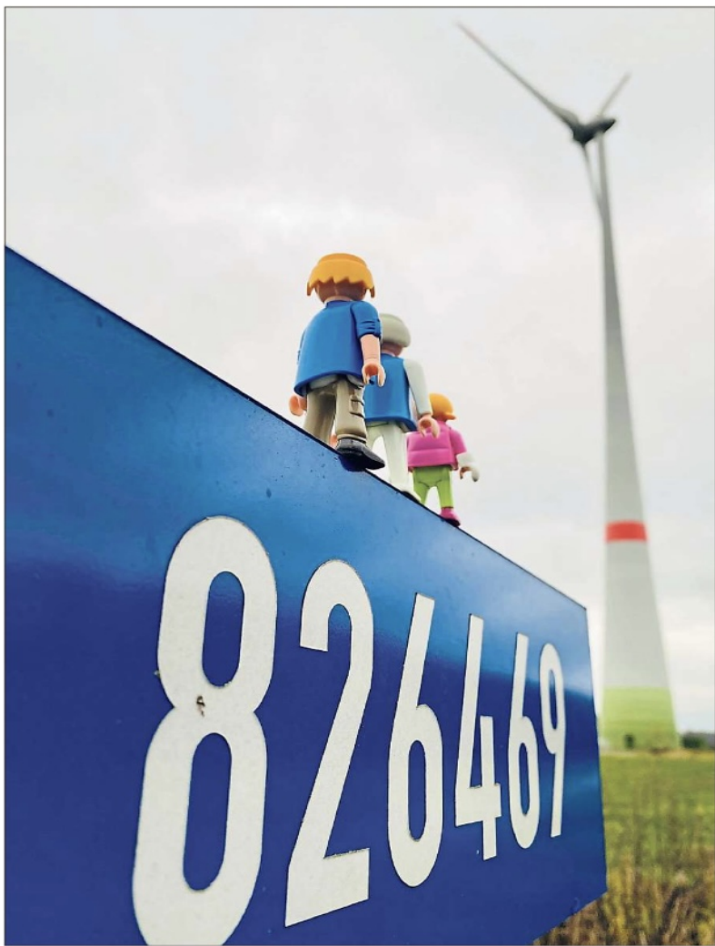
Im Gewerbegebiet Aurea in Rheda-Wiedenbrück drehen sich bereits Rotoren von zwei Windrädern der Rhewie. Eines davon ist die Anlage 826469. Das geplante Windrad für Langenberg wäre jedoch deutlich höher. Das liegt vor allem an den extralangen Rotorblättern, die die Anlage leiser machen. Foto: Nienaber
